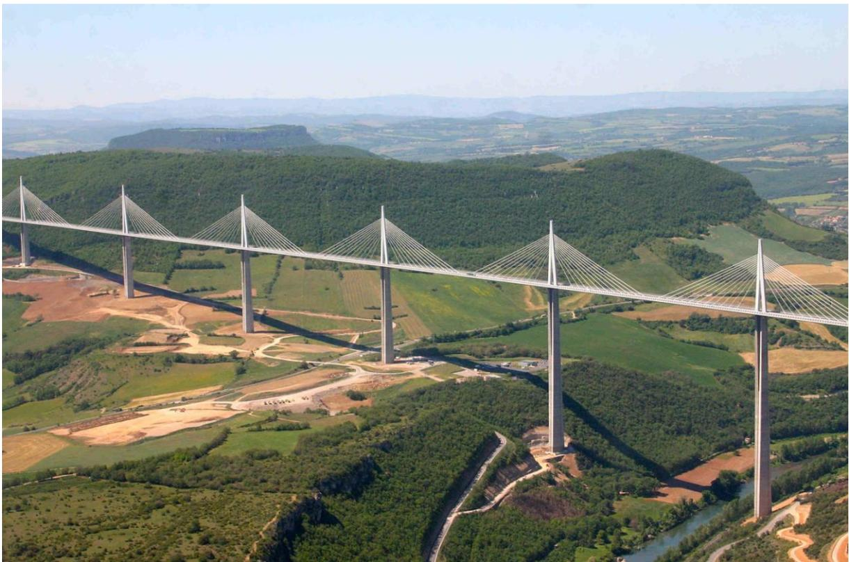
Nach Severac kam bald im tiefer gelegenen Tal das 2004 fertiggestellte Viaduct de Millau (Pfeilerhöhe bis 343 m, mit 2460 m Länge die längste Schrägseilbrück der Welt)
