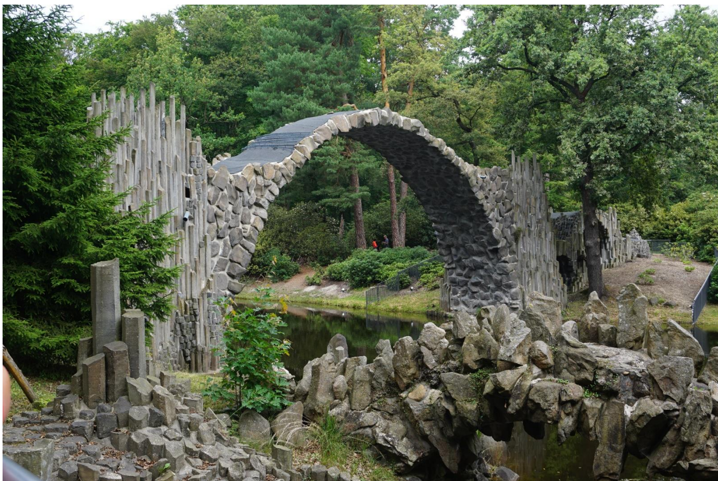
Der nicht so spektakuläre Blick von der anderen Seite auf die Brücke.
