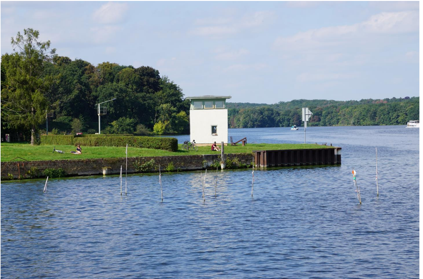
Ehemalige Grenzkontrollstelle für die Binnenschifffahrt nach Westberlin an der Bertini-Enge.
