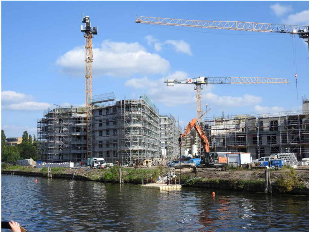
In Potsdam wird viel gebaut.
