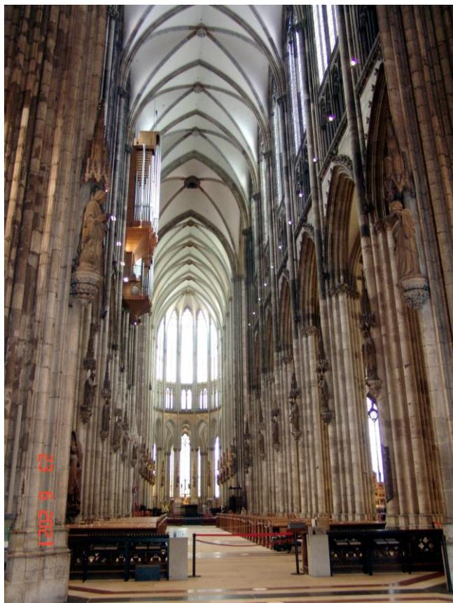
Über 100 Pfeiler tragen das Gewölbe. Im Mittelschiff (rechtes Foto) mit dem Chor im Osten erreichen die Pfeiler eine Höhe von 43,35 Meter. Das linke Foto zeigt das südliche Seitenschiff. Beachte, wie weit oben eine der Orgeln angebracht ist.
