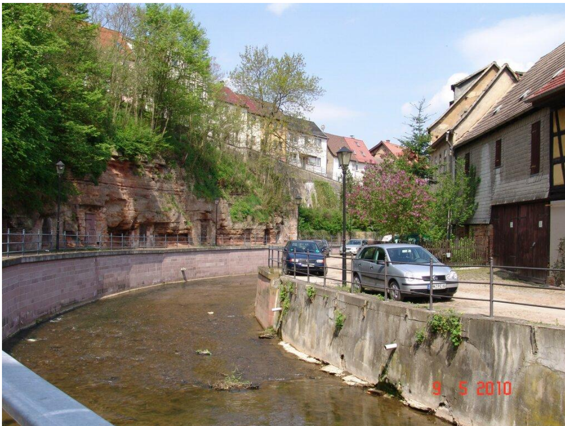
Die Roda und eine Häuserzeile, die auf den Buntsandsteinfelsen steht (in die Felsen hat man Keller getrieben).
