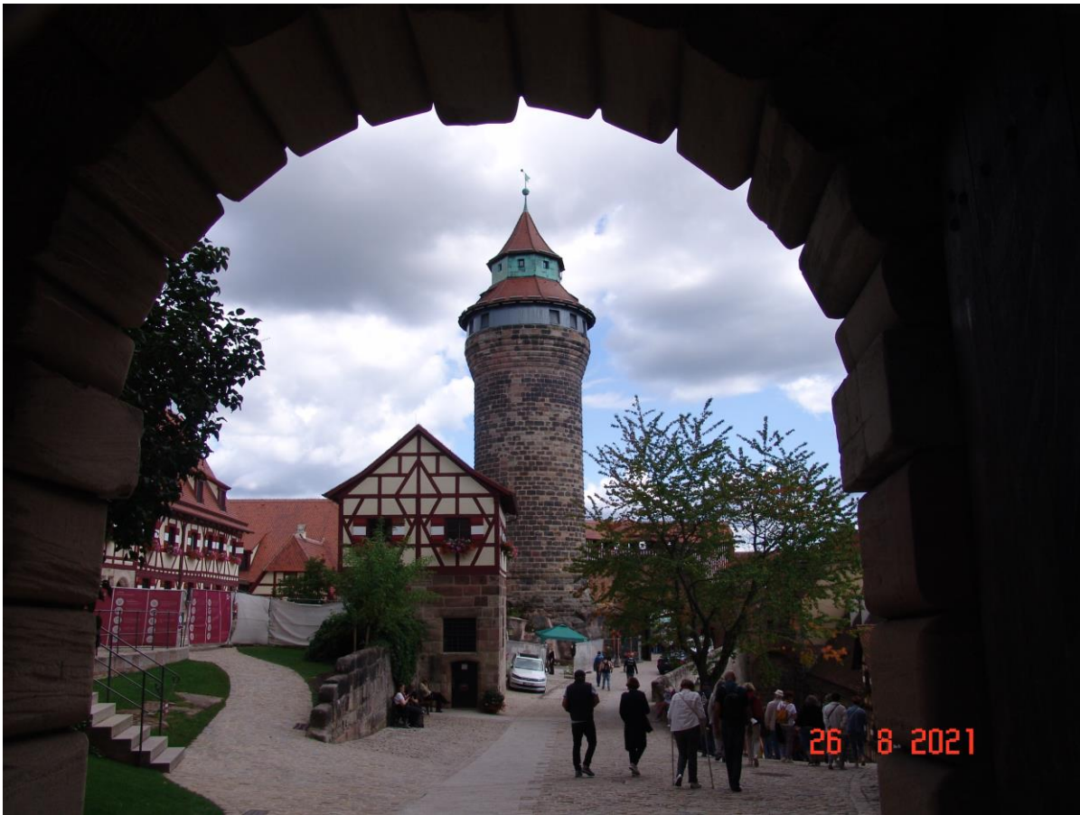
Blick auf den Sinnwellturm.
