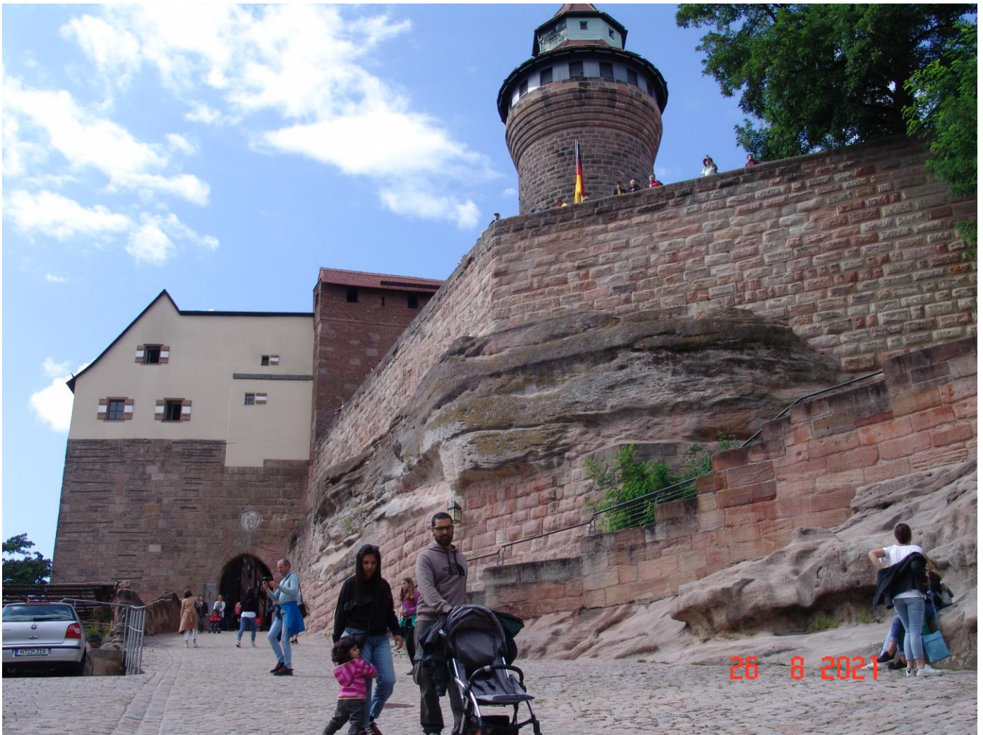
Der zentrale Eingang zur Burg.
