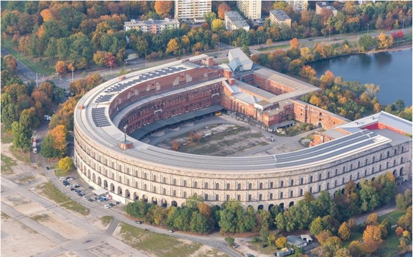
Aufnahme der Kongresshalle im heutigen Zustand. 1937 bis 1939 waren hier täglich 1400 Arbeiter beschäftigt.
