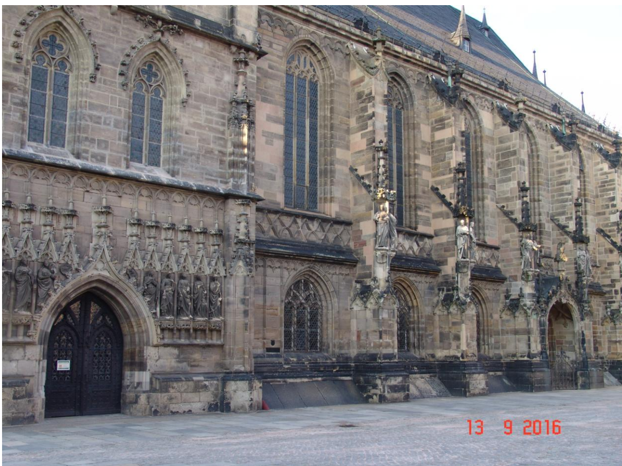
Blick auf die Längsseite der Kirche.
