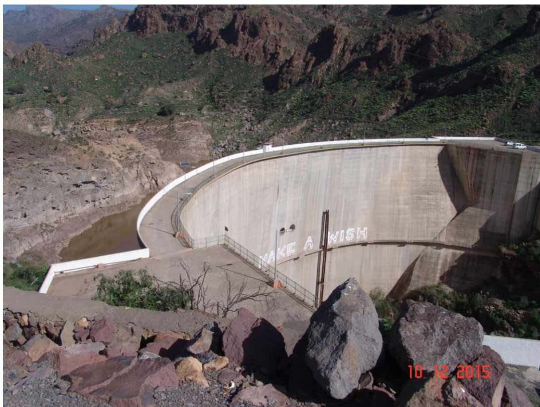
Der Staudamm. Wie man sieht, ist wenig Wasser im Becken.
