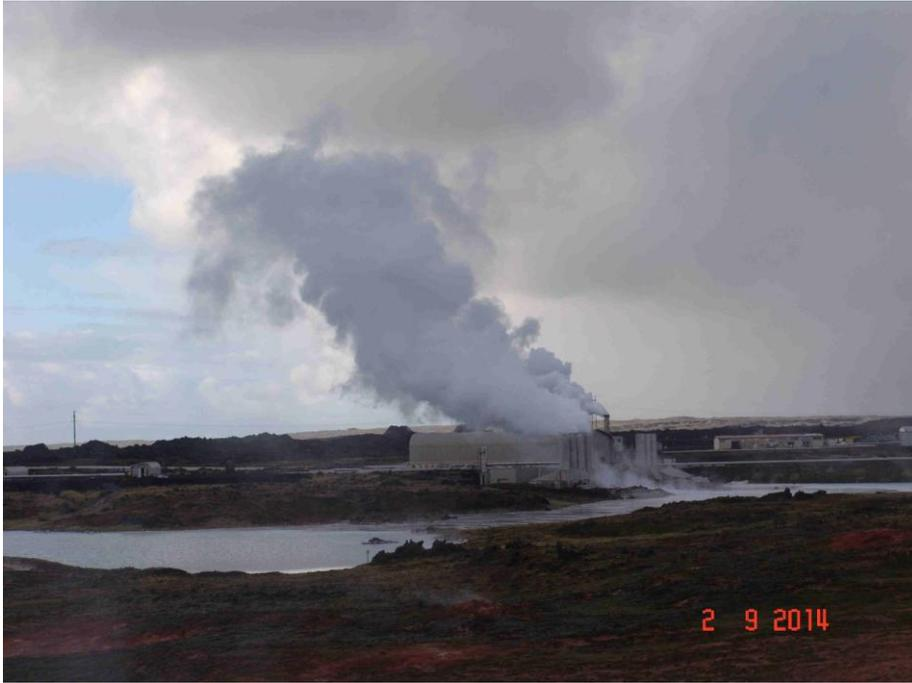
Nahebei steht ein Kraftwerk, in dem das heiße Wasser aus der Erde über Turbinen in elektrischen Strom für die Hauptstadt verwandelt wird und danach in Rohren weiter geleitet wird.
