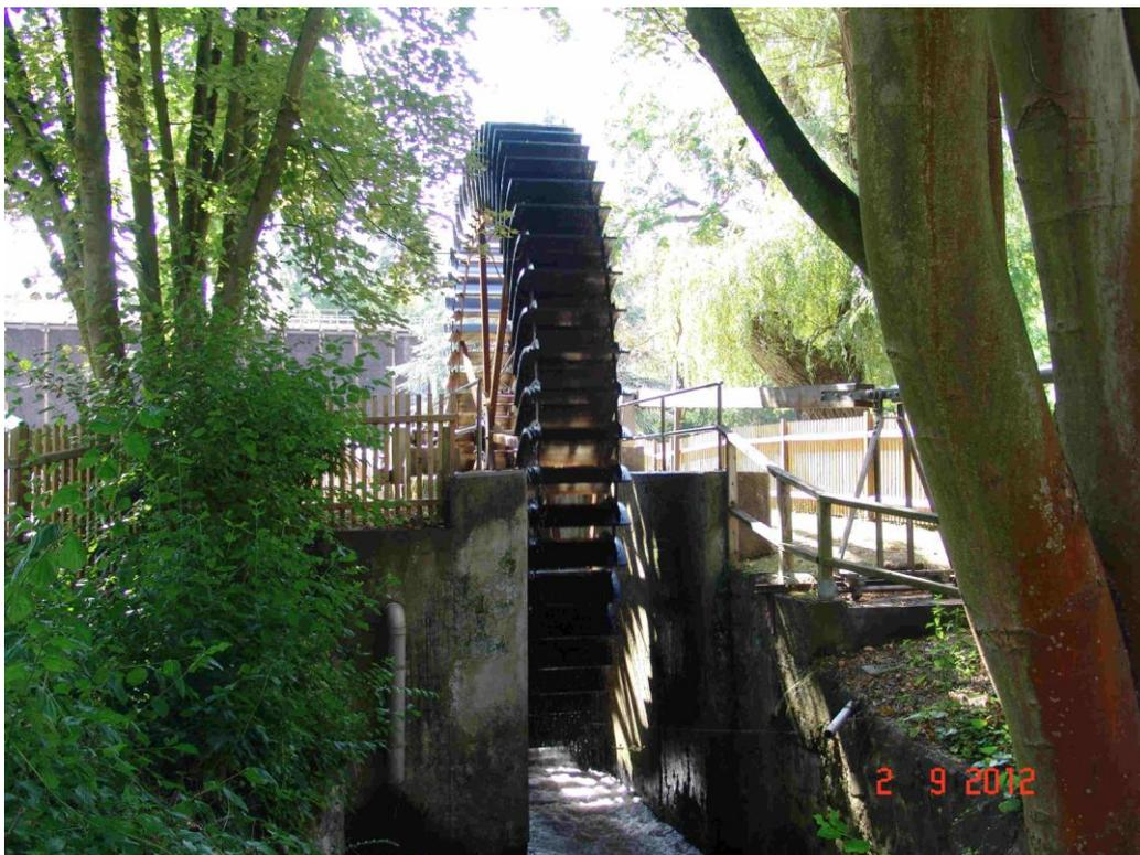
Ein unterschlächtiges Wasserrad treibt über ein Gestänge Pumpen für zwei Gradierwerke an, welche die Sole nach oben in 9 m Höhe drücken.
