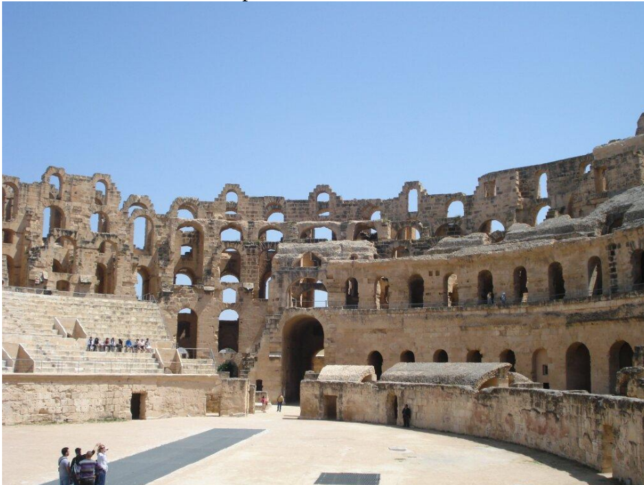
Eine Innenansicht. 1695 hatten sich im Inneren Rebellen verschanzt. Um sie zu überwältigen, wurde die Außenmauer teilweise abgebrochen. Danach war das Theater dem Verfall Preis gegeben. Erst in den letzten Jahrzehnten begann man mit Restaurierungsarbeiten. So wurden die Ränge links im Bild schon restauriert (dort wo im Bild einige Leute sitzen).
