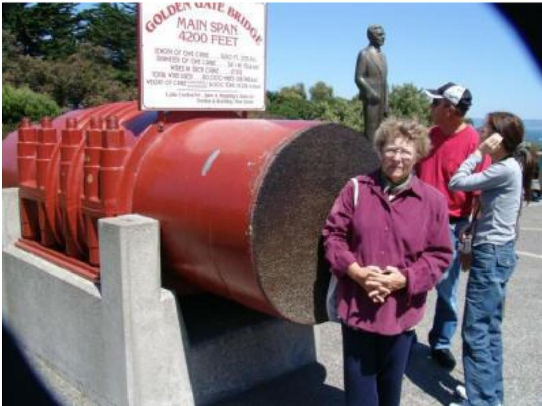
Die Brücke wird von solchen Kabeln gehalten, von denen jedes aus 27 572 einzelnen Drähten besteht. Im Hintergrund die Statue des Konstrukteurs, Joseph Strauss. Die Brücke wurde von 1929 bis 1937 gebaut und hat inzwischen mehrere Erdbeben überstanden, darunter das starke von 1989. An zwei Tagen haben wir Downtown(=Stadtzentrum) und die Gegend des Fischereihafens zu Fuß abgelaufen.
