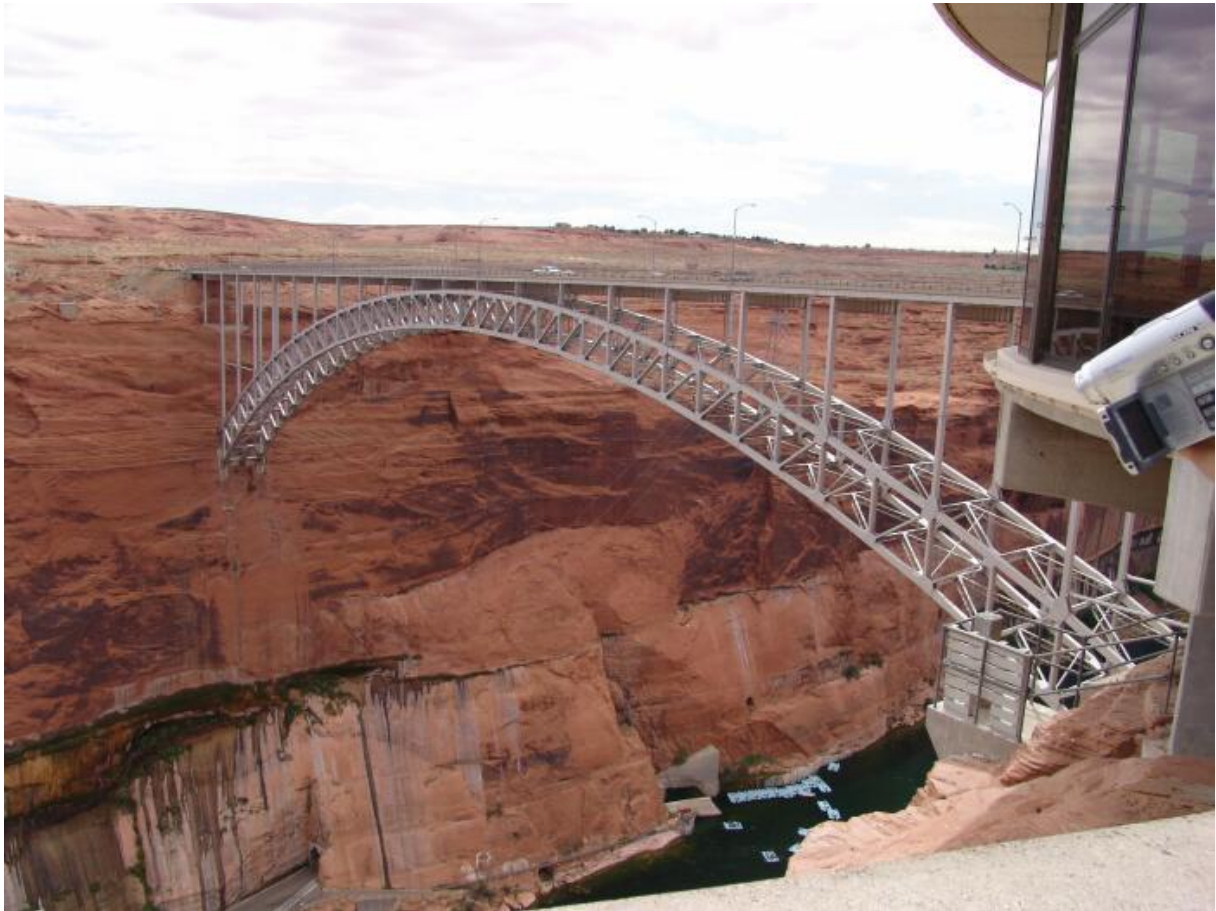
Die Straßenbrücke hinter der Staumauer, unten die Fortsetzung des Colorado als Abfluss aus dem Lake Powell.
