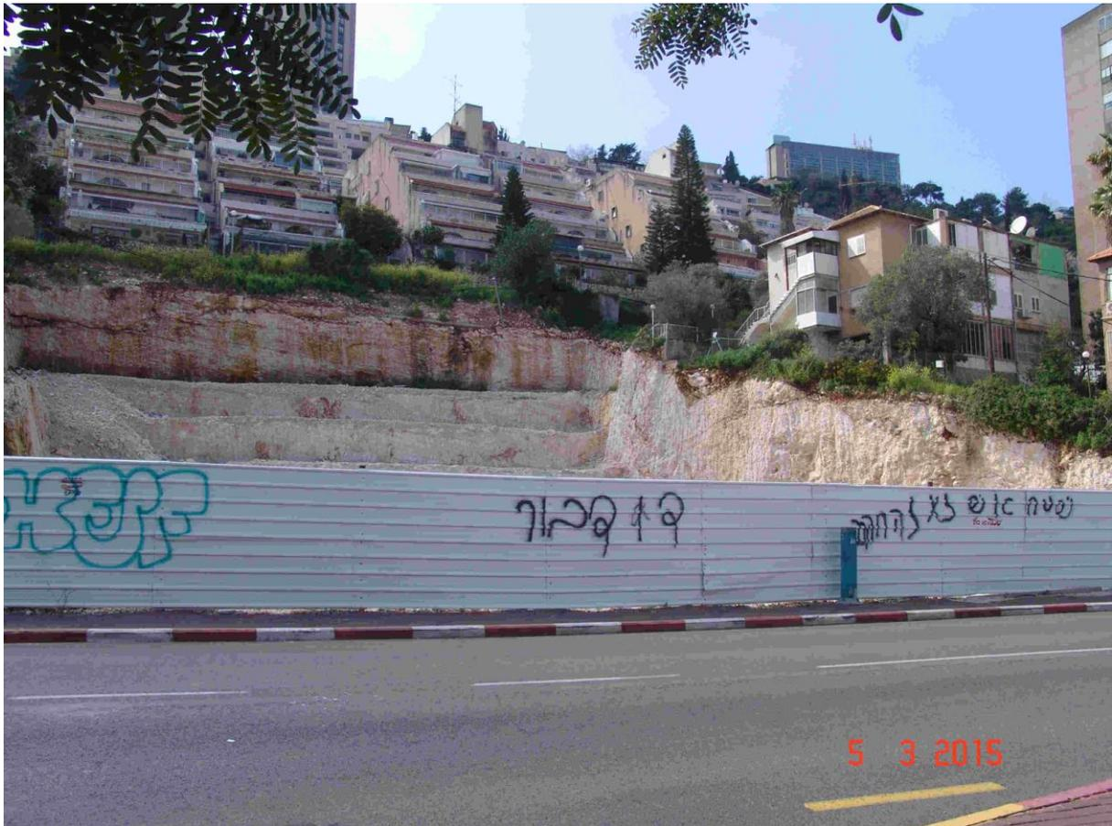
Das Foto dieser Baugrube habe ich aus zwei Gründen in den Bericht aufgenommen. Einmal soll es demonstrieren, wie steil die Hanglage am Karmel ist, so dass man die Häuser tief in die Erde setzen muss. Weiterhin zeigt das Foto das weiße Kalkgestein, aus dem der Berg besteht.
