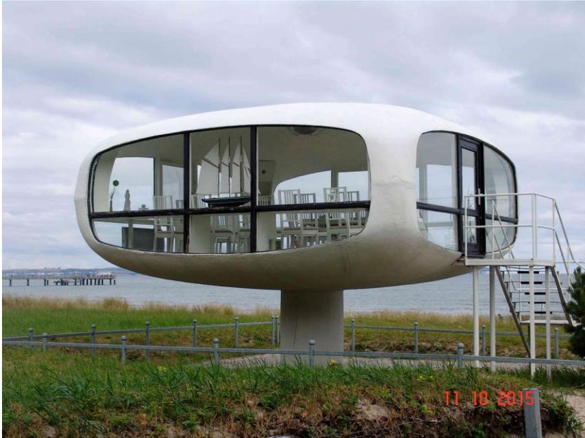
Am östlichen Ende des Strandes entdeckte ich diesen attraktiven Hyperschalenbau aus Beton des DDR-Architekten (von der Insel Rügen) Ulrich Müther (gestorben 2007). Er baute u.a. auch in den Golfstaaten, in Finnland und Jordanien. Heute wird der Bau vom Standesamt genutzt.
