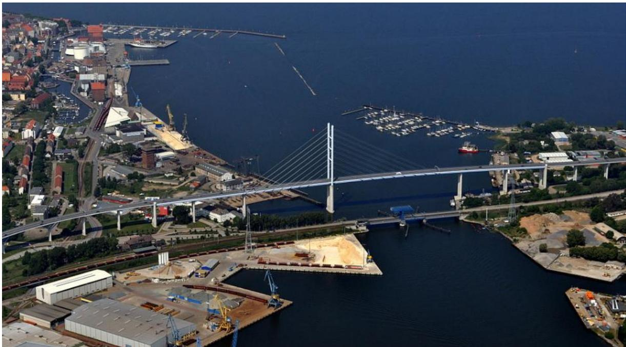
*Vom Hafen aus waren auch die beiden Brücken vollständig zu sehen, die die Insel Rügen mit dem Festland verbinden. Hier eine Luftaufnahme. Vorn der 1936 gebaute Rügendamm mit einer Zugbrücke für die Schiffsdurchfahrt, dahinter die 2007 errichtete Rügenbrücke, welche im Mittelteil so hoch ist, dass Schiffe darunter hindurch können (die Durchfahrthöhe beträgt 42 m). Vor 1936 war der Zugang zur Insel nur mit Fährschiffen möglich. Fähren verkehren auch heute noch nach Rügen.*
