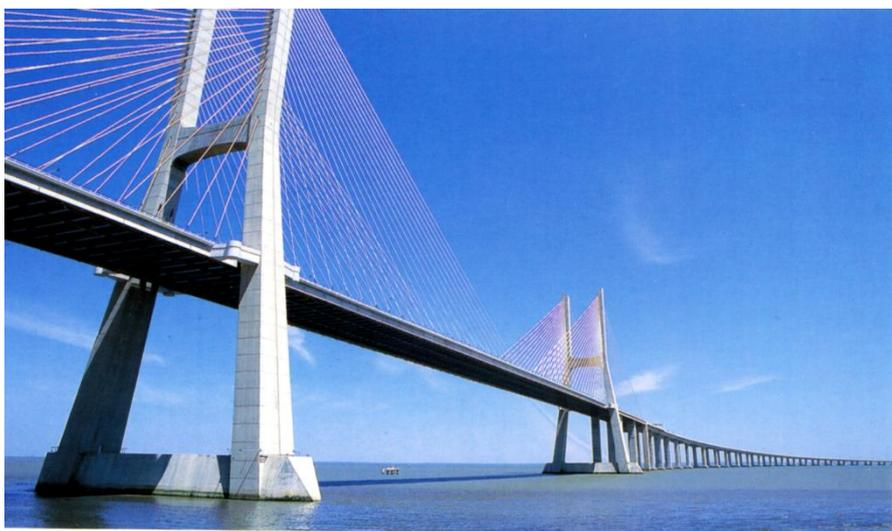
Die nahe dem Expo-Gelände stehenden ersten zwei 150 m hohen Pfeiler der Ponte Vasco da Gama. Sie gewährleisten einen regen Schiffsverkehr auf dem Tejo.
