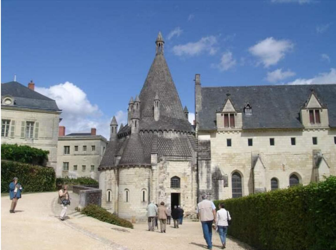
Die um 1060 entstandene achteckige Kirche der Anlage mit Rauchabzug in der Mitte des kegelförmigen Daches, von der man erst 1870 erkannte, dass sie mal als Küchenbau diente.
