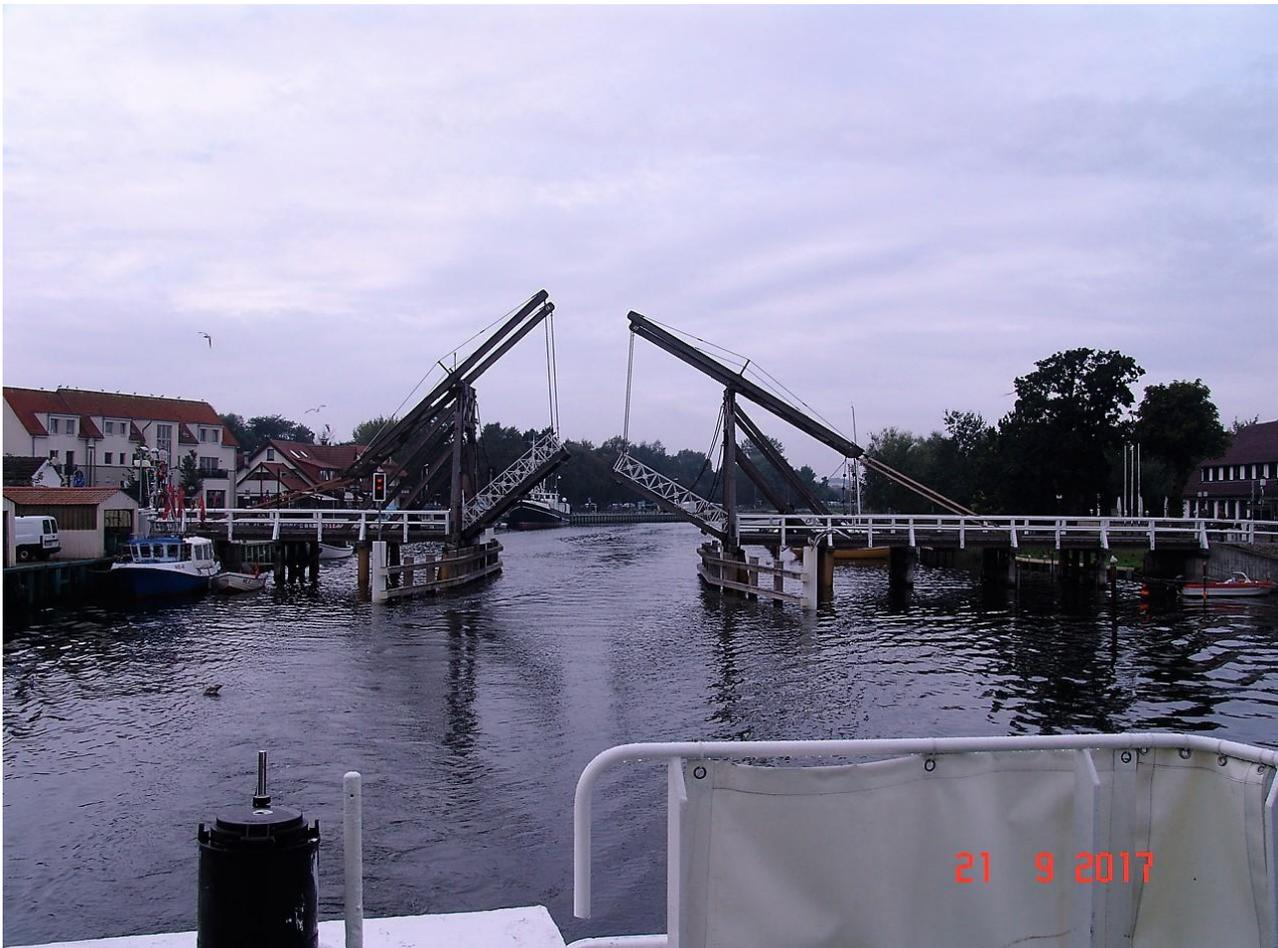
Die geöffnete Klappbrücke von Wieck. Wir waren gerade mit unserem Schiff durchgefahren. Die Brücke dürfen Fußgänger und im PKW die Einwohner von Wieck kostenlos benutzen (immer nur ein Fahrzeug, Zugang mit einer elektronischen Karte, mit ihr kann man den, den Zugang versperrenden, metallischen Boller in die Tiefe absenken).
